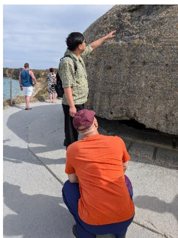
Wang Qi Bin relevant les impacts sur un blockhaus
